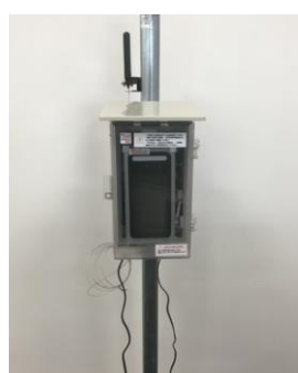
単管パイプに固定
